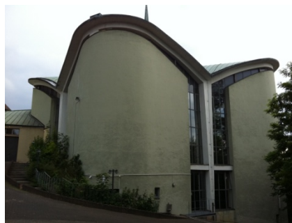
... und der moderne Erweiterungsbau
