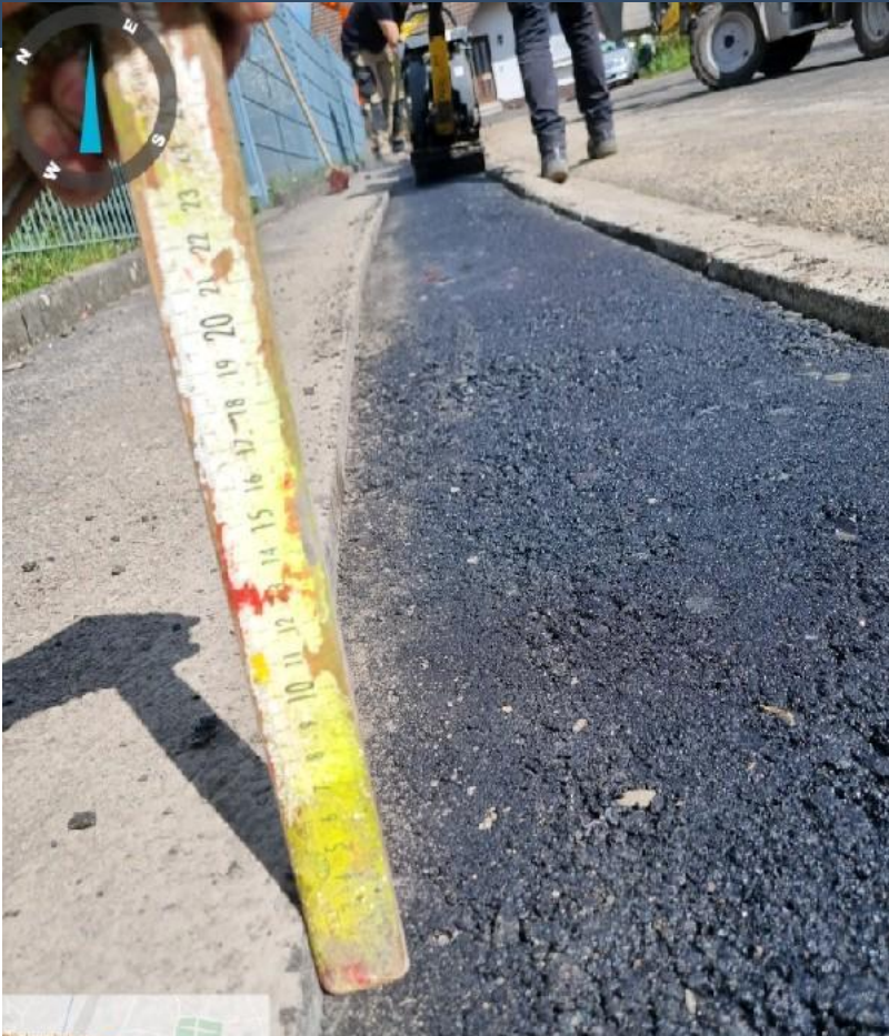
Tragschicht am selben Tag eingebaut
