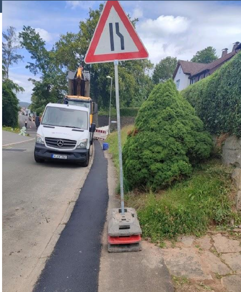
Feinschicht ein paar Tagen später eingebaut
