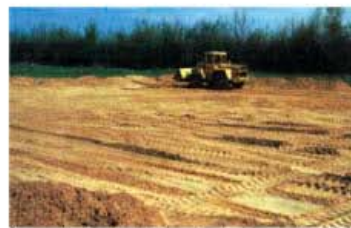
Besondere Landschaften erfordern besondere Maßnahmen: Nährstoffreiche Schichten werden abgetragen, damit Sandmagerrasen entstehen kann.
