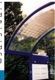
Solarbushaltestelle in Wasserlos
