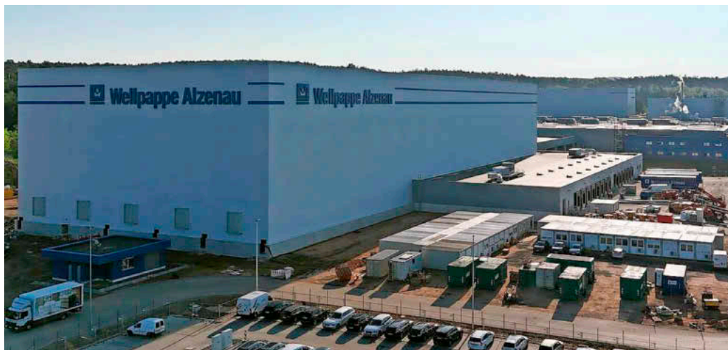
Wellpappe Alzenau GmbH: Produktion von Wellpappenverpackungen für unterschiedlichste Anwendungen.
