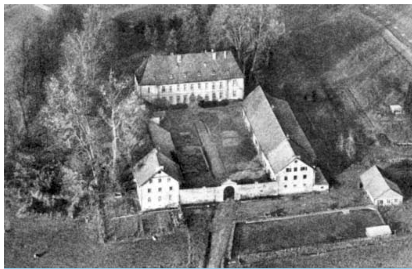
Das Hofgut Maisenhausen in seinem Zustand vor der Renovierung.
