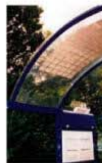
Solarbushaltestelle in Wasserlos
