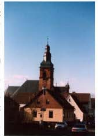
Weithin sichtbar ist die zwischen 1914 und 1920 nach einem Plan des Architekten Marschall aus Ludwigshafen im neobarocken Stil erbaute Katharinenkirche. Finanzielle Grundlage für den Bau war eine Stiftung von Ludovica Freifrau von des Bordes, der Schwester des Dichters Clemens Brentano, in Höhe von 2000 Gulden im Jahr 1851.
