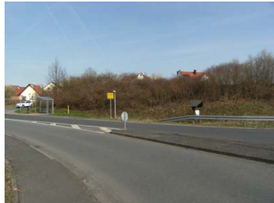
Blicke auf den Lärmschutzwall
