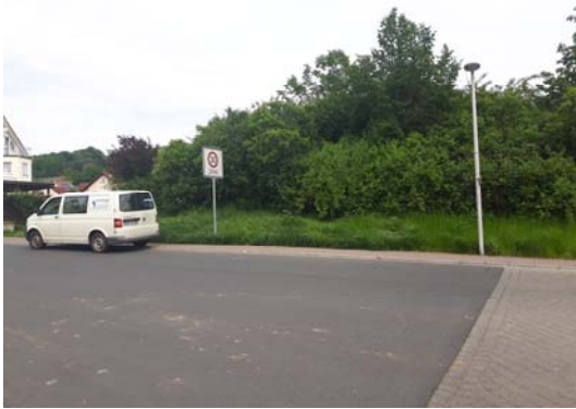
Blick auf den Lärmschutzwand (Foto Ing. Büro Jung)
