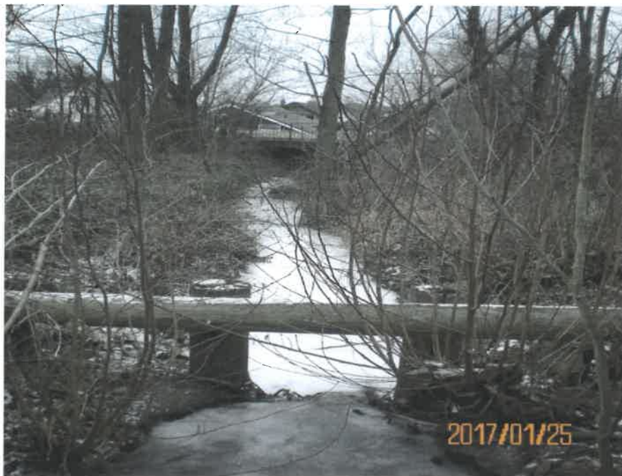
Abb. 15 (Verbuschung im Bereich Grobstoffrückhalt)
