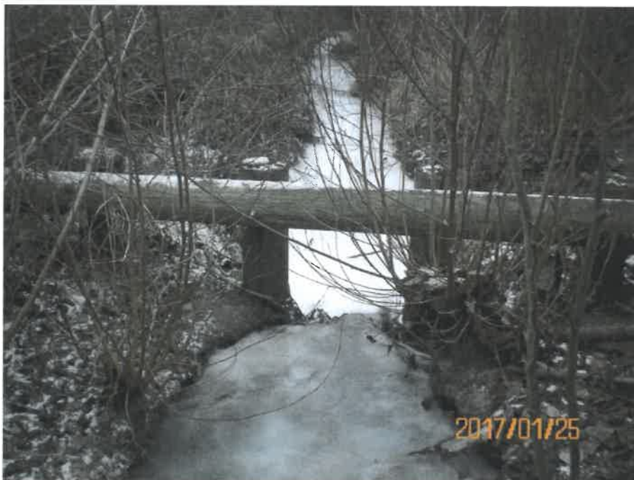
Abb. 14 (Verbuschung im Bereich Grobstoffrückhalt)
