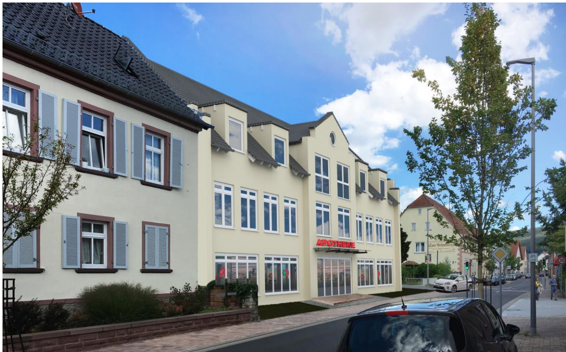
Ansicht Hanauer Straße (Architekturbüro Geissler)
