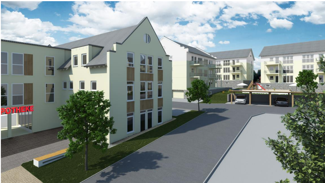
Ansicht von Süden in den Innenhof (Architekturbüro Geissler)
