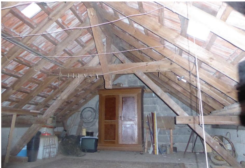
Foto 5: Dachgeschoss des Gebäudes südlich des Wohnhauses. Auch hier liegen die Ziegel auf dem Dachgebälk auf. Zahlreiche Spalten im Dach sowie im Bereich der Fenster ermöglichen auch hier einen freien Einflug für Fledermäuse oder Vögel.
