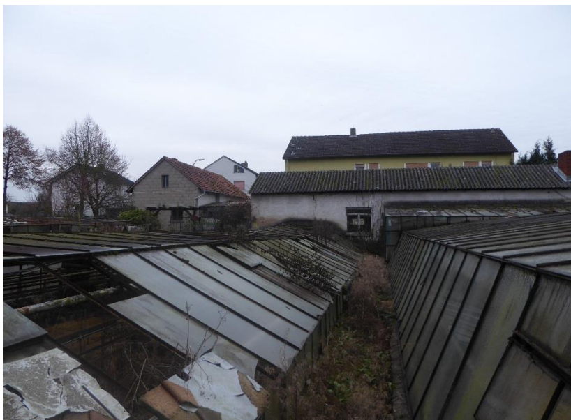
Bild 11: Bild über ehemalige Treibhäuser der Gärtnerei nach Westen. Im Bildzentrum: ehemaliges Gebäude der Gärtnerei mit dahinter liegendem Wohngebäude.
