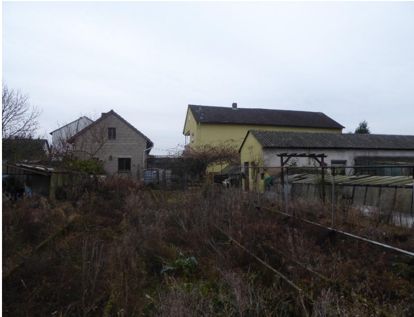
Foto 4: Blick vom Osten des ehemaligen Gärtnerengeländes auf die Gebäude. Bildhintergrund (mittig): derzeit noch genutztes Wohngebäude; links Gebäude südlich des Wohnhauses; mittig im Vordergrund: Gebäude der ehemaligen Gärtner.
